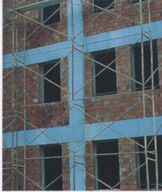
Şekil 02. Yapılarda WALLMATE TB ile ısı köprülerinin yalıtılması
