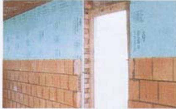
Şekil 42. Sandviç duvar uygulama
