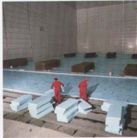
Şekil 38. Soğuk hava deposu döşeme uygulaması
