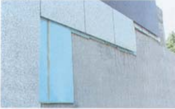
Şekil 40. Giydirme cephe uygulama
